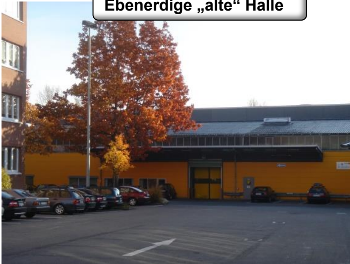
Ebenerdige „alte“ Halle
