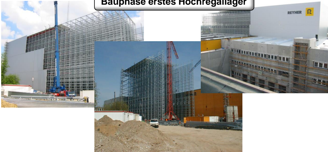
Bauphase erstes Hochregallager
